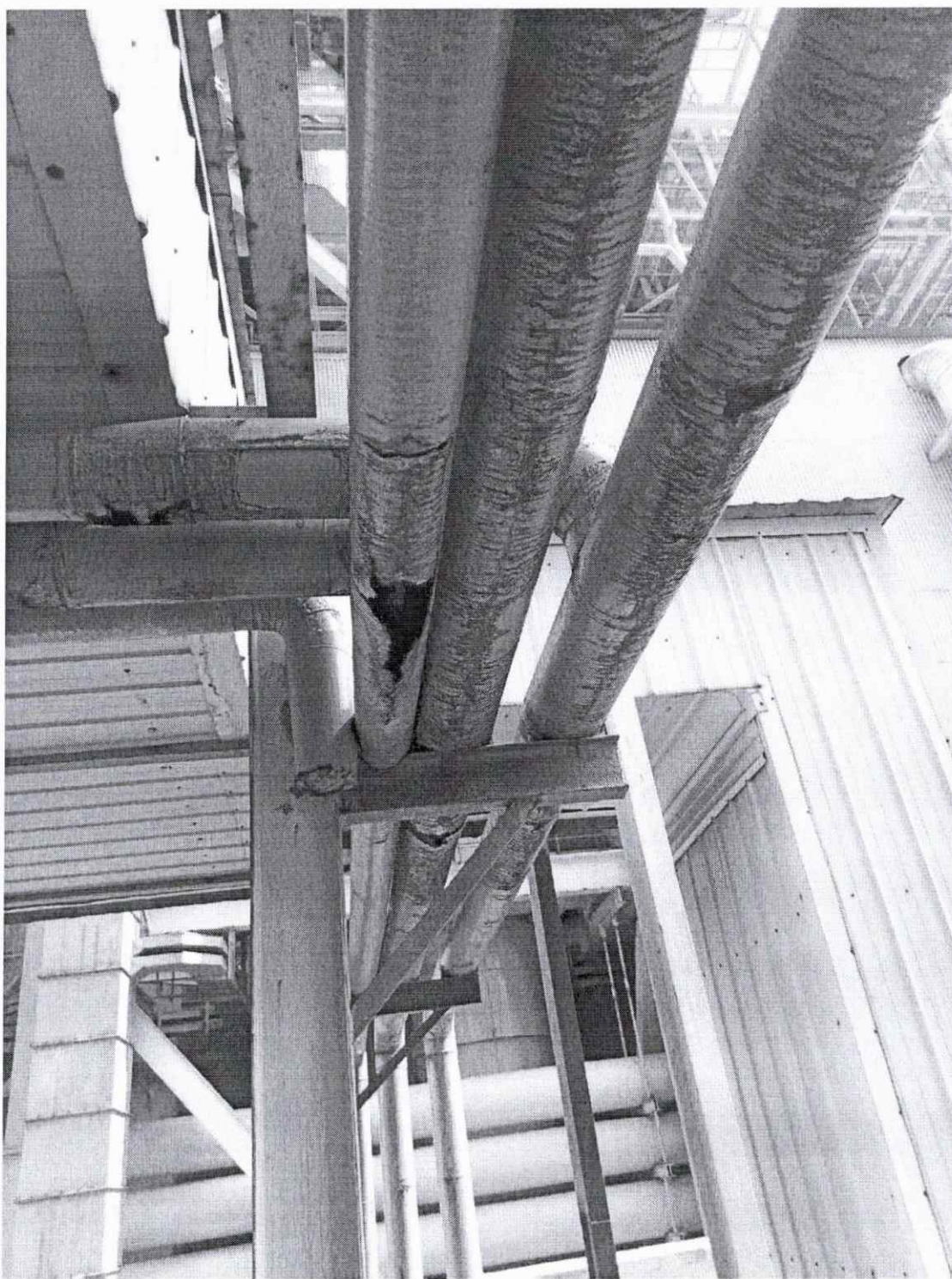
需要更换的管道保温及支架防腐
